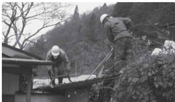
高圧洗浄による屋根の除染作業（大信大屋地内）
