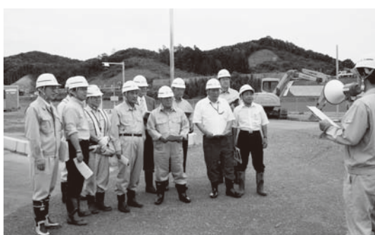
白河中央スマートインターチェンジ建設現場
