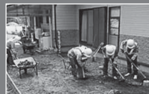
▲表土はぎ取り
