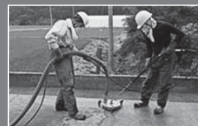
▲アスファルト高圧洗浄
