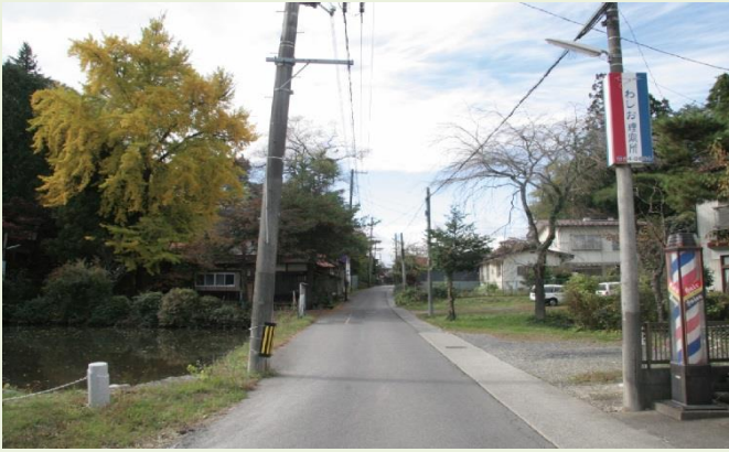
Dゾーン現況写真
