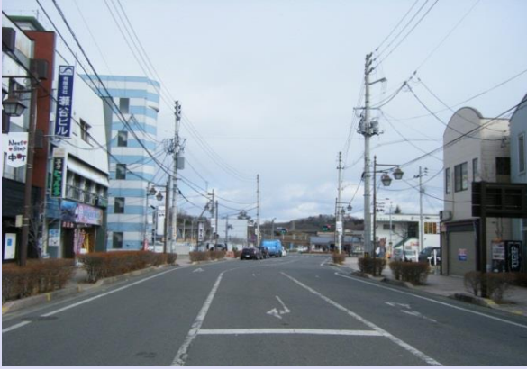
Gゾーン現況写真
