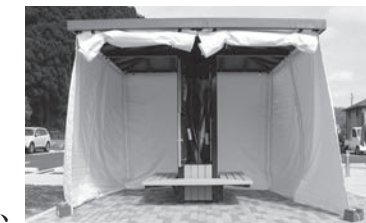
▲テントに変わった防災東屋
