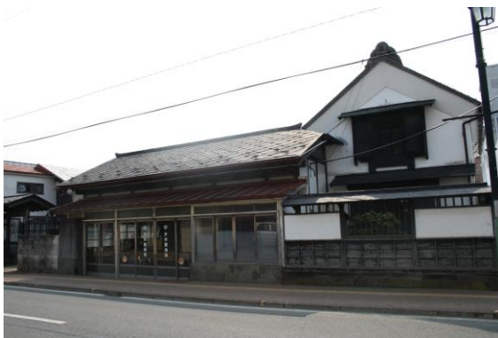
③ 今井醤油店建造物群（天神町）
