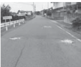
〈道路穴ぼこ修繕後〉
