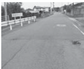
〈道路穴ぼこ修繕前〉
