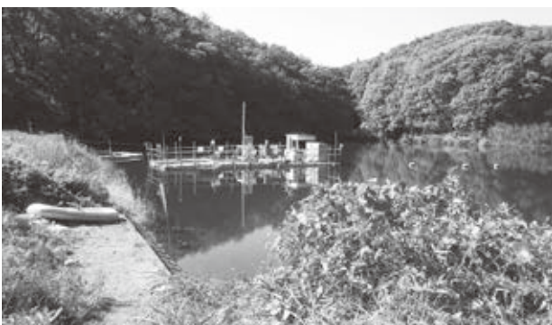
〈飯沢ため池放射性物質対策工〉
