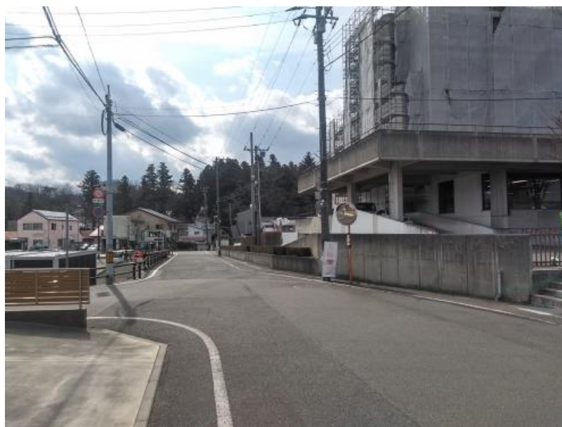
写真 現況写真
