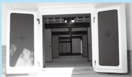
重厚な扉は防火の役割も
