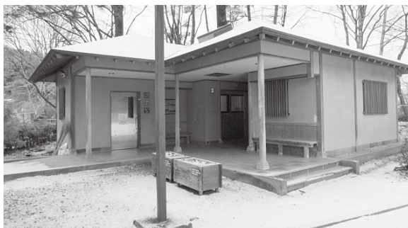
南湖公園南側トイレ
