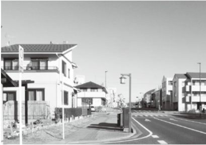
無電柱化の「小峰通り」
