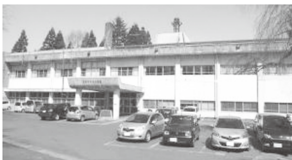
築50年以上経過し、老朽化が著しい中央公民館
