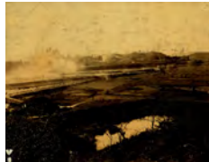
◀機関庫移転工事現況写真 (大正5年、歴史民俗資料館蔵)
