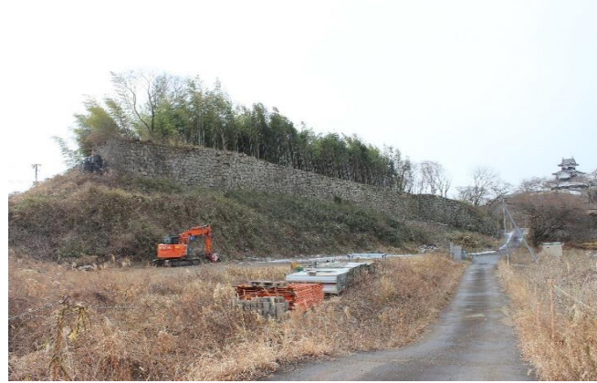
【鎮護神山樹木伐採状況】
