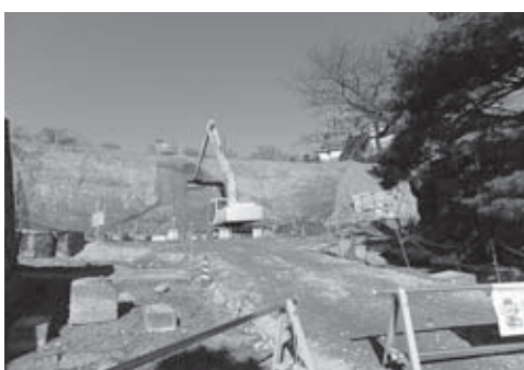
小峰城石垣修復状況
