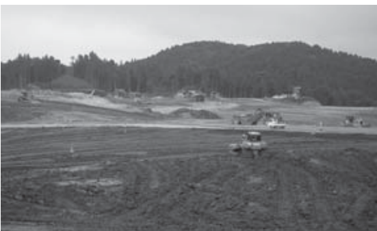
工業の森・新白河B工区 造成状況
