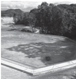
配水池施工予定地
