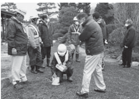
除染現場の現地調査（大信地内）
