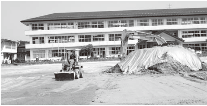
五箇小学校 表土除去工事
