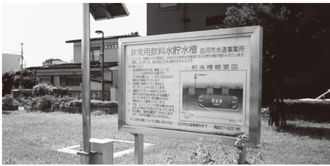
耐震型貯水槽（郭内地内）
