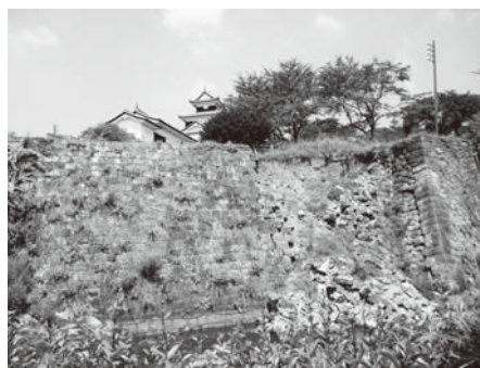
石垣が崩壊した小峰城
