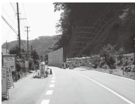
県道白河石川線法面復旧工事(搦目地内)
