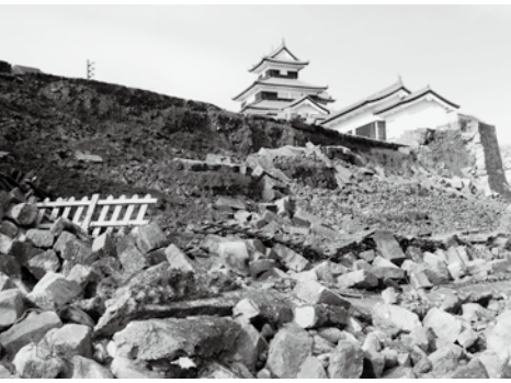
小峰城本丸南面の石垣崩落の状況
