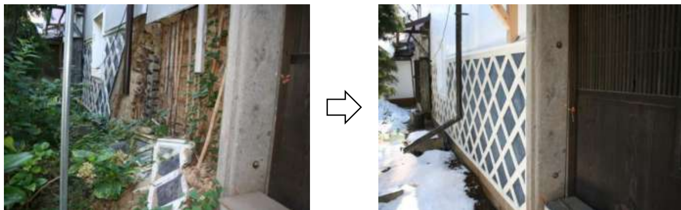
外壁・なまこ壁修理
