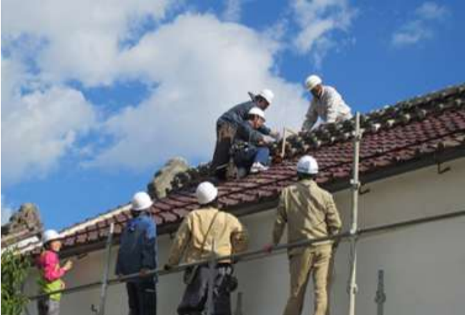
瓦屋根の実測 (平成24年11月14日)
