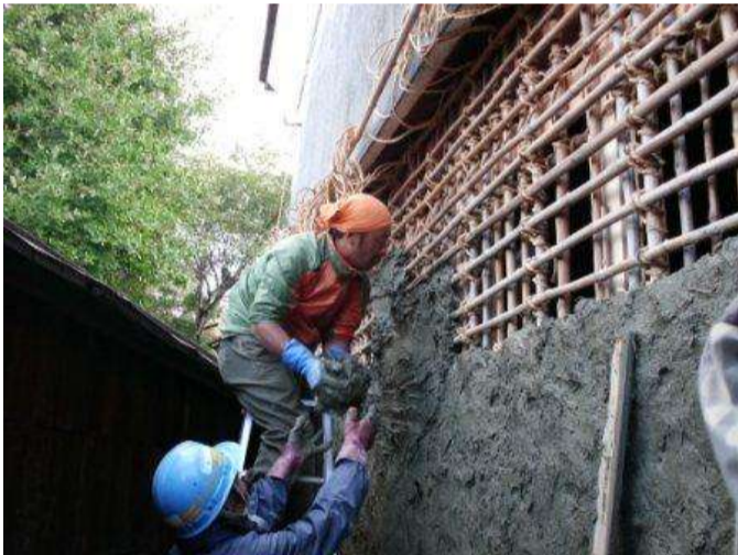
伝統工法による土蔵の土壁塗り (平成24年10月21日)
