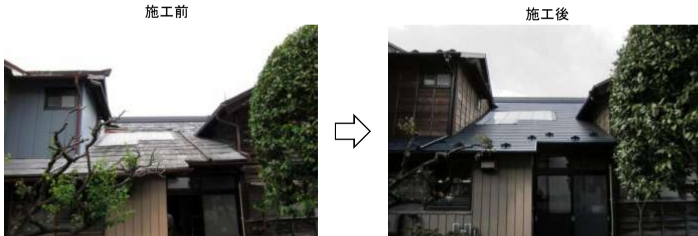
屋根修理・板壁設置
