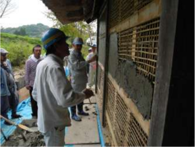
伝統工法による古民家の土壁塗り (平成24年10月14日)
