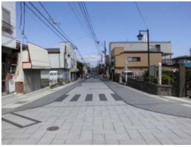
整備後(石畳による舗装)
