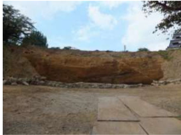
石材撤去の終了した本丸南面
