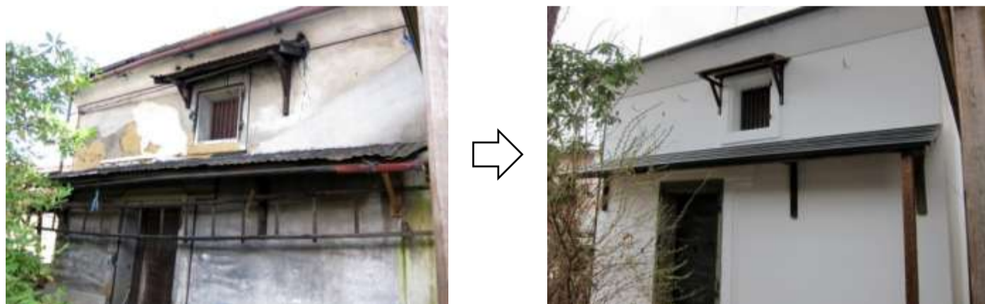
屋根・外壁・庇・修理
