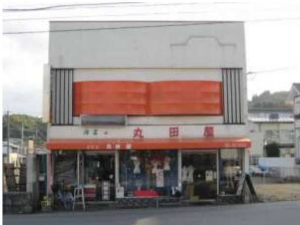
店舗の新築(勾配屋根・庇・付柱・窓格子の設置)
