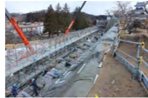
▲本丸北面修復工事の様子
