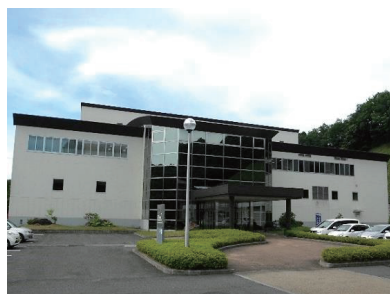
西白河地方リサイクルプラザ
