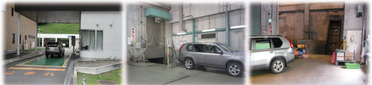
① 計量所 計量を行い、降ろす場所を案内いたします。 ② 西白河地方クリーンセンタープラットフォーム（降ろす場所） ③ 西白河地方リサイクルプラザプラットフォーム（降ろす場所）
