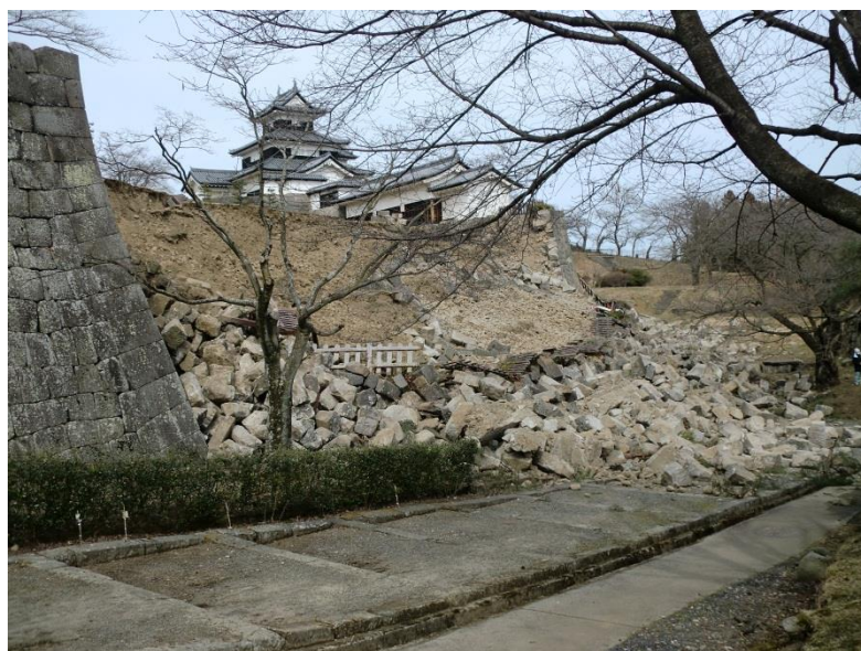
震災により崩落した小峰城跡の石垣
