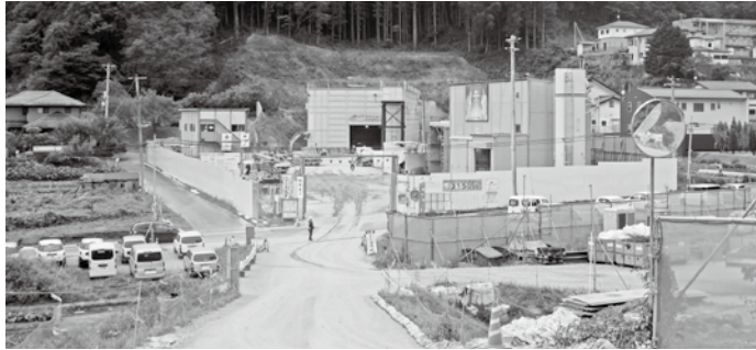
国道294号白河バイパス 南湖トンネル
