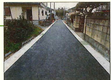
側溝改修状況
