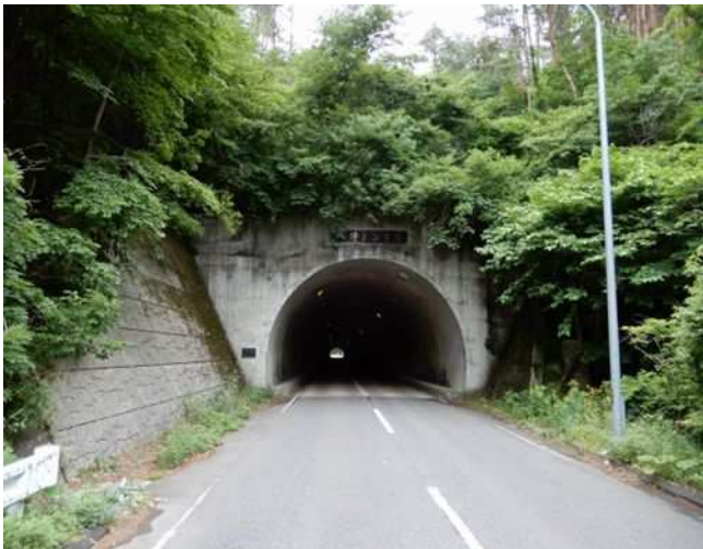
大信トンネル
