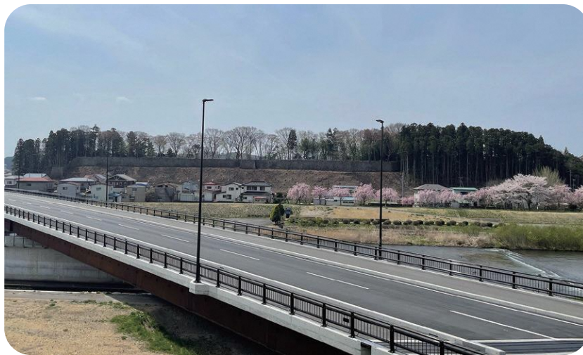
全線開通した国道 294 号白河バイパス（小峰大橋から小峰城の石垣を望む）
