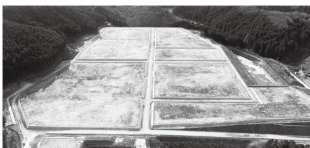
仮置き場となっていた土地(旗宿大久保地内)
