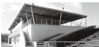
陸上競技場管理棟
