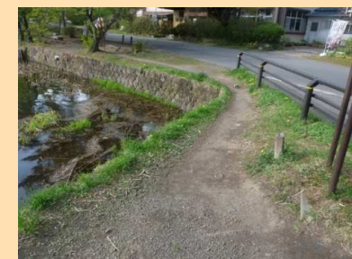
〔北東湖岸園路整備箇所〕
