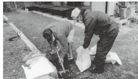
▲除染作業の様子
