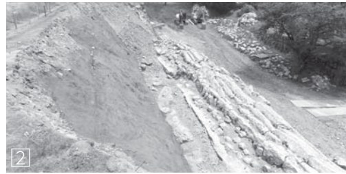
①最も被害が大きかった本丸南面石垣 ②石垣の背面に用いたコンクリートが倒れた姿（本丸南面） ③樹木とともに石垣が崩れた竹之丸南面
