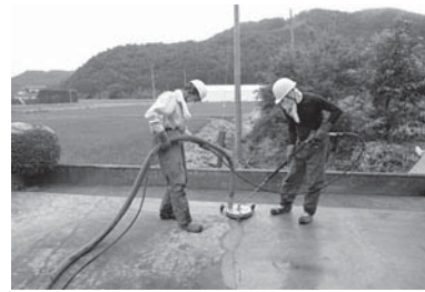
▲コンクリート高圧洗浄
