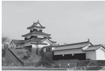
▶伝統工法で積み上げられた本丸南面の石垣 ▶修復中の三重櫓と前御門
