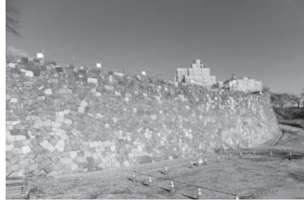
▶伝統工法で積み上げられた本丸南面の石垣 ▶修復中の三重櫓と前御門
