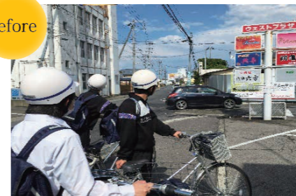
歩道から横断歩道を渡る際の危険な段差(市道登町線)
