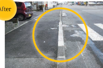
現地を点検した後、歩道の段差を一部取り除いて改善しました。
