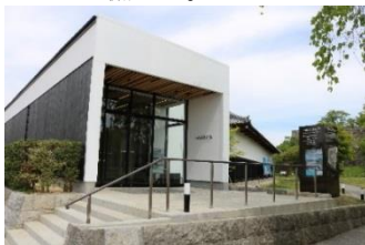
【増築部分外観】
