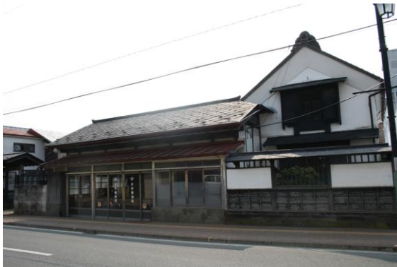
③ 今井醤油店建造物群（天神町）
