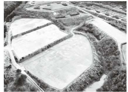
大信地域仮置き場搬出完了
