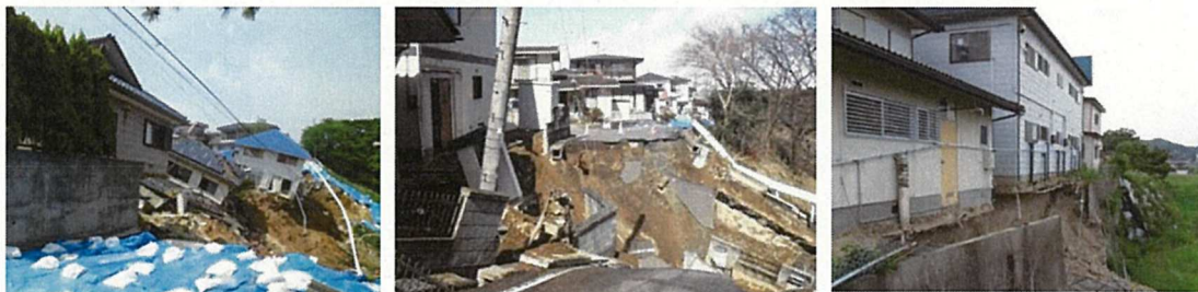
【法面や擁壁の被害状況（東日本大震災）】
