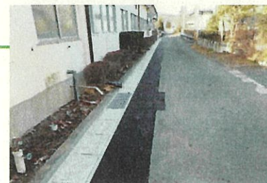
側溝改修状況
