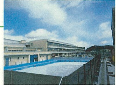
建設工事の様子
