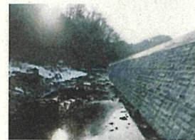
改修した護岸
