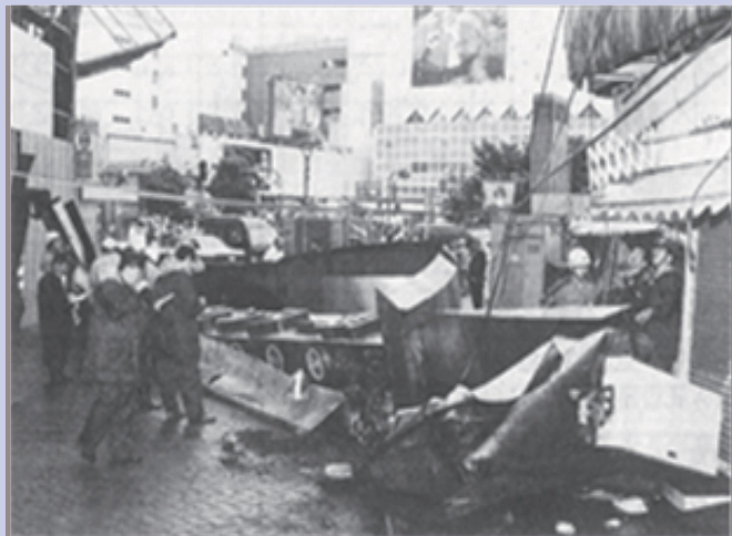
台風で落下した時の様子
