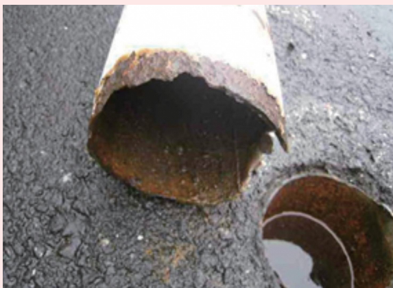
ポールの根腐れによる倒壊
