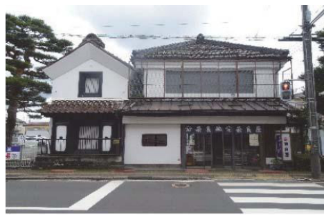
奈良屋呉服店建造物群
