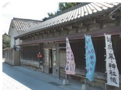
本家富川屋染物店建造物群
