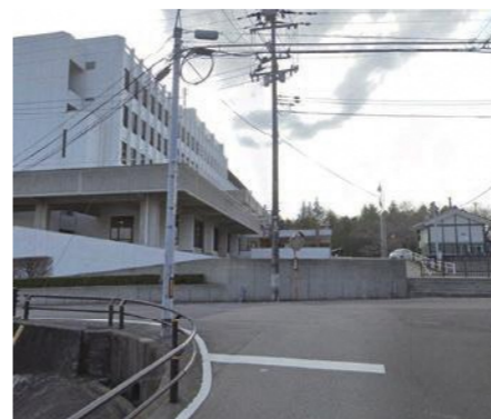
④ 廃道予定箇所 東側から
