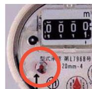
水道メーターには、パイロットと呼ばれるパーツがあります。通常、水を使用している場合はクルクルと回り、使用していない場合は止まっています。全ての蛇口を閉めている状態でもパイロットが回っている場合は、漏水していると判断できます。
