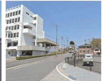
③ 廃道予定箇所 南側から
