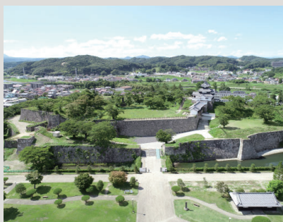
▲石垣の復旧が完了した小峰城
