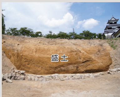
▲本丸南面石垣の裏側（南から）
