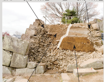
新しい時期の盛土 古い時期の盛土
