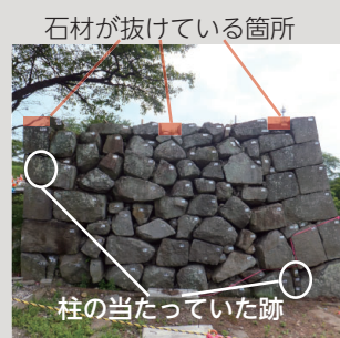
▲修復前の清水門東側の石垣
